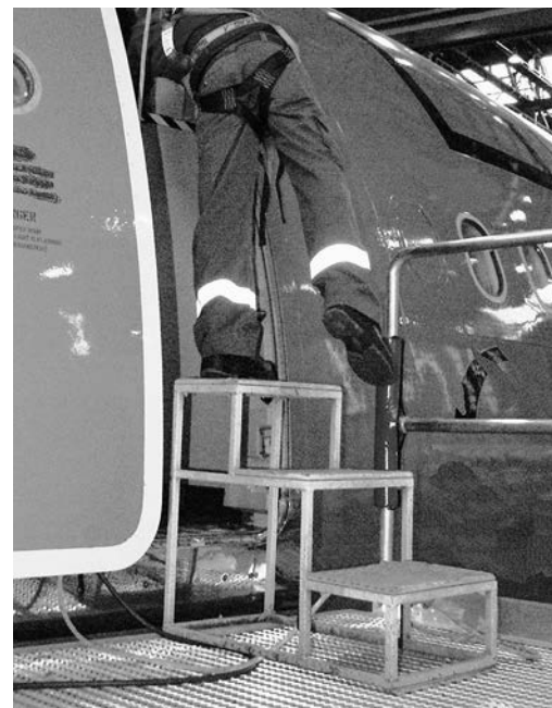
6 Absturzsicherung beim Einsatz eines Dreitritts
